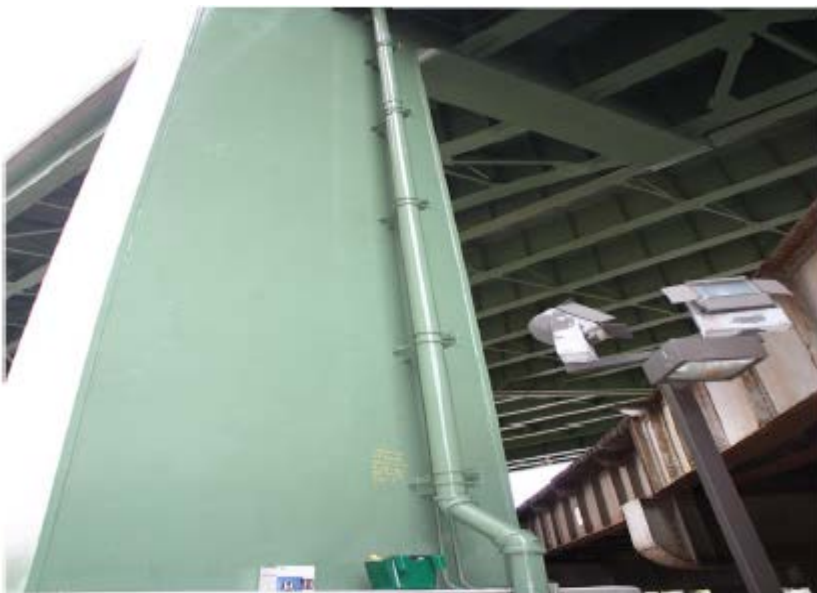
BRIDGE 67, PIER 10E
