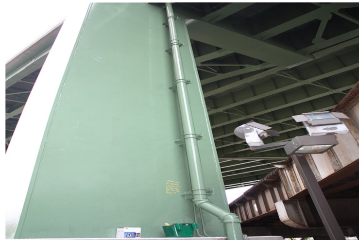
BRIDGE 67, PIER 10E
